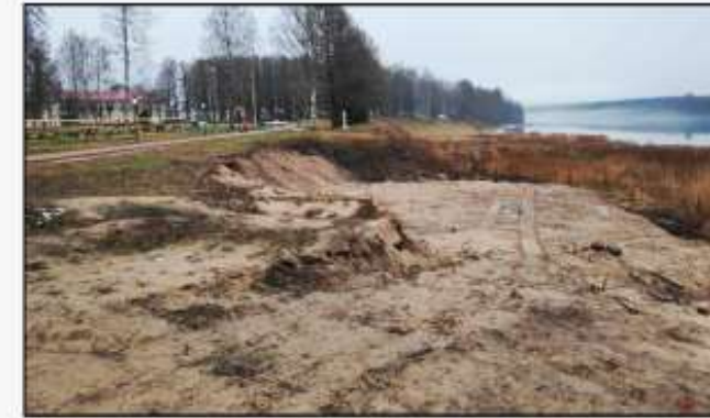
3. Обширная эрозия природного склона, продолжающаяся после механического нарушения почвенного покрова
