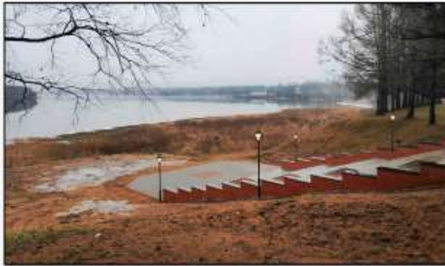
1. Незавершенное благоустройство и отсутствие берегоукрепления
